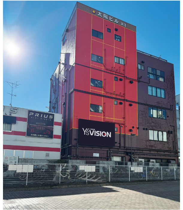
Y'sVISION 大和駅前設置箇所全景
