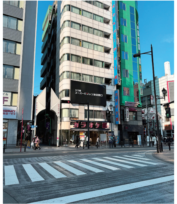
カラ館スーパービジョン池袋西口設置箇所全景
