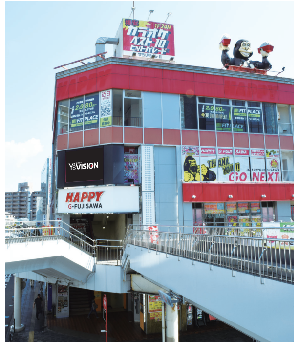
Y'sVISION藤沢北口設置箇所全景
